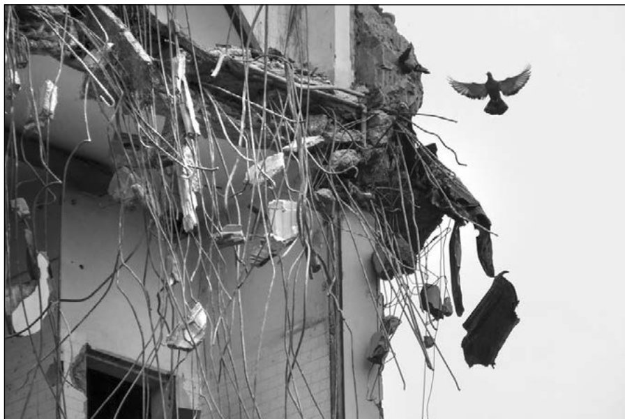
Luglio 2018 - la demolizione di Villa Salus.
