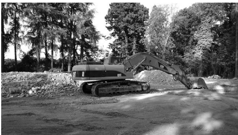
Luglio 2018. La distruzione è completata.
