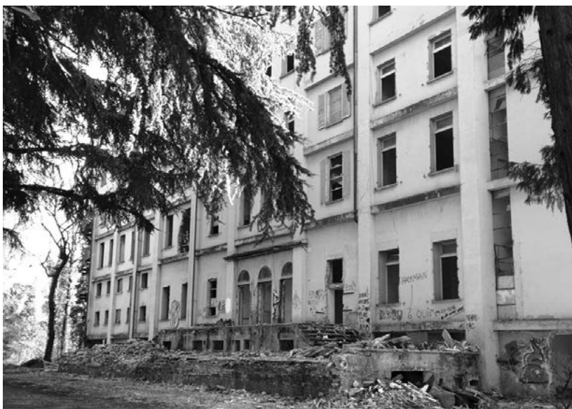
Febbraio 2018. La demolizione della struttura inizia, chissà perché, proprio dalla storica scalinata.
