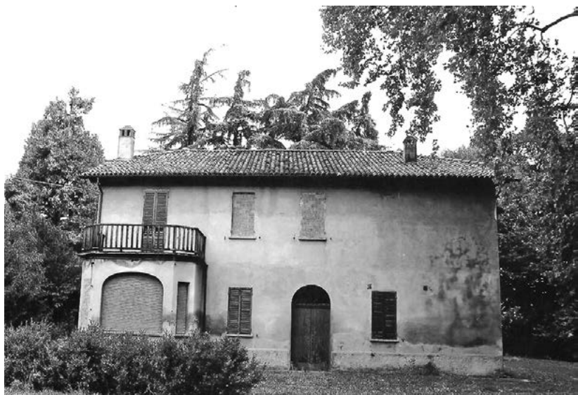
Una recente immagine frontale della “Casa del giardiniere”.
